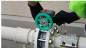
①ワイヤーロックを外し、バルブを回して、給水管の栓を開く。
