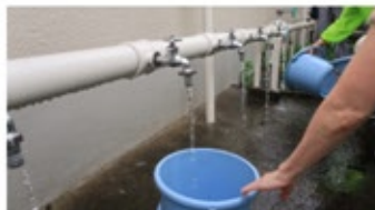
②給水管の蛇口をひねる。
